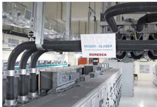
DURESCA 12 кВ 2500 А. Подключение к КРУЭ
